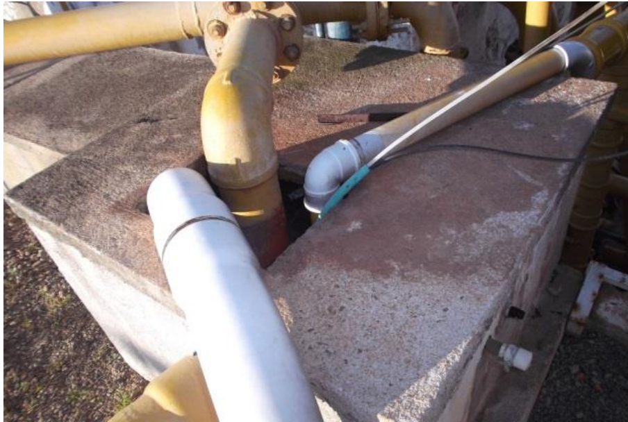
Figura 37 - Adição de cloro e flúor na água já tratada.
