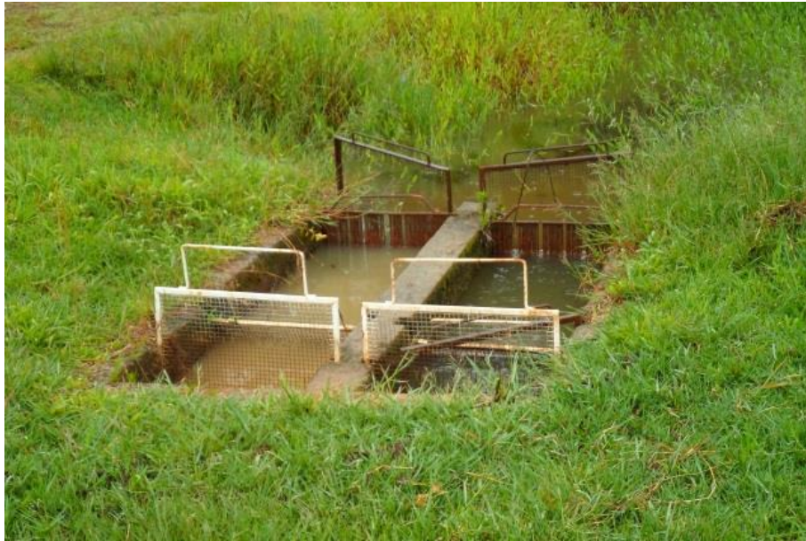
Figura 14 – Captação e Gradeamento no Ribeirão Cachoeirinha.
