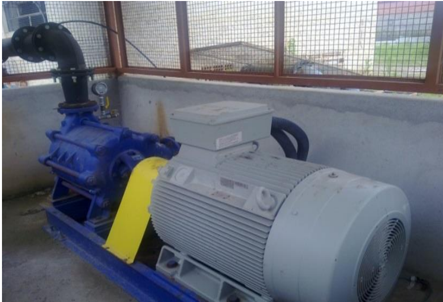
Figura 16 - Bomba de recalque da captação.
