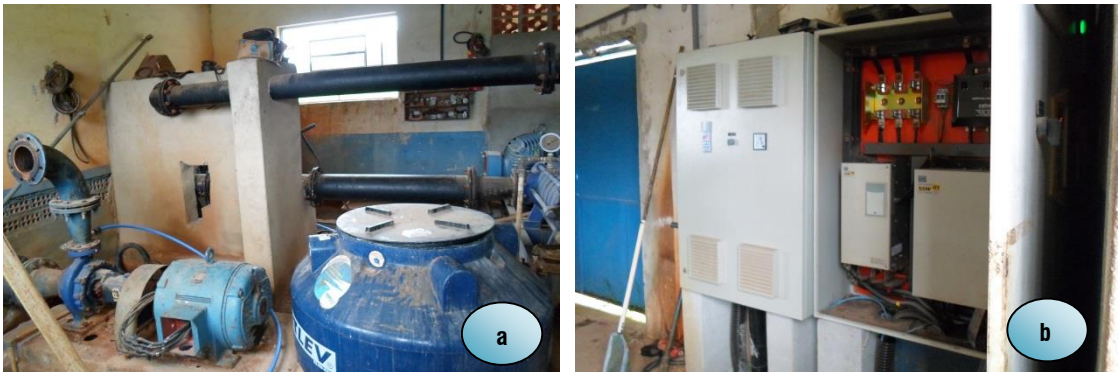
Figura 17 – Captação no Ribeirão Cachoeirinha: a) Interior da casa de bombas; b) painel de telecomando.
