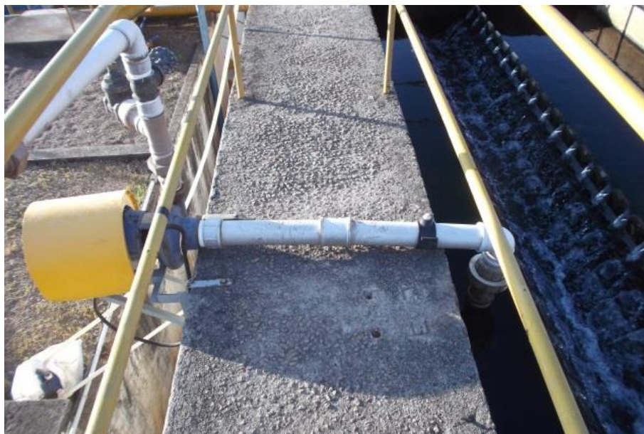
Figura 34 - Booster de recalque da água do decantador para o filtro auxiliar.
