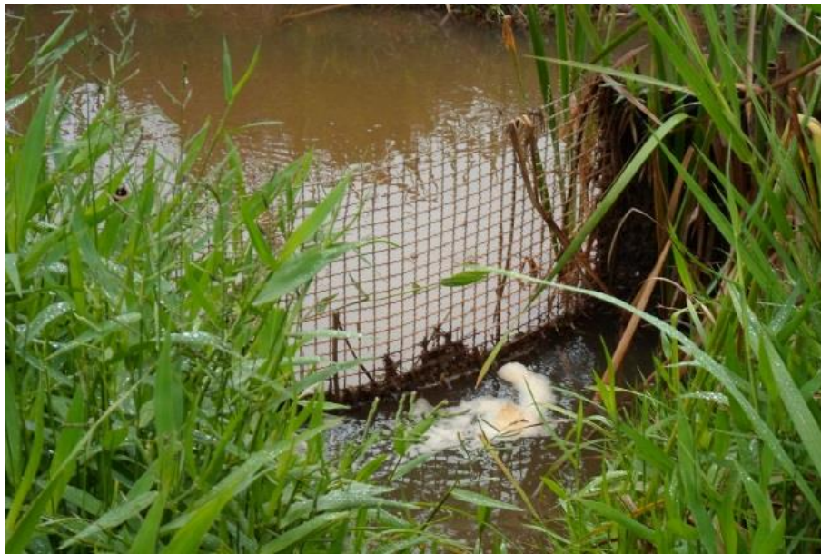
Figura 18 - Captação e Gradeamento no Ribeirão Vargem Grande.
