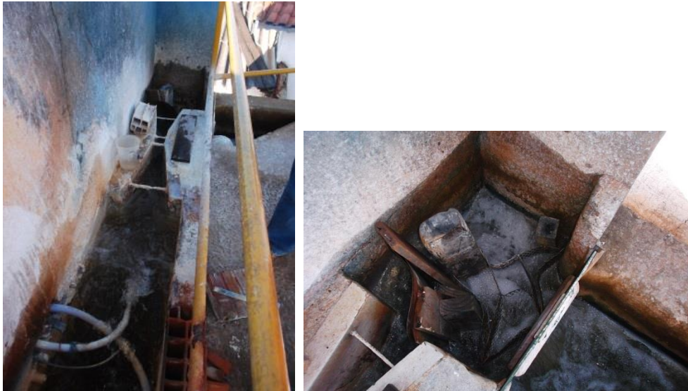
Figura 30 – Entrada de água bruta na calha Parshall .
