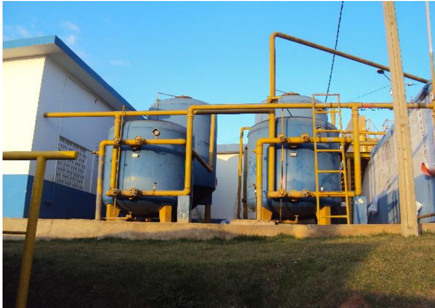
Figura 29 - ETA 1 : Decantadores e Filtros.
