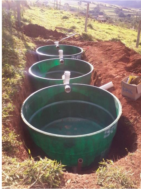
Figura 59 - Instalação de Fossa Séptica Modelo Embrapa.
