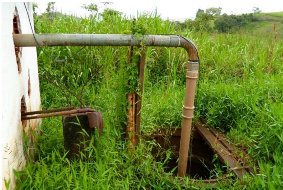
Figura 20 - Poço de captação de água.
