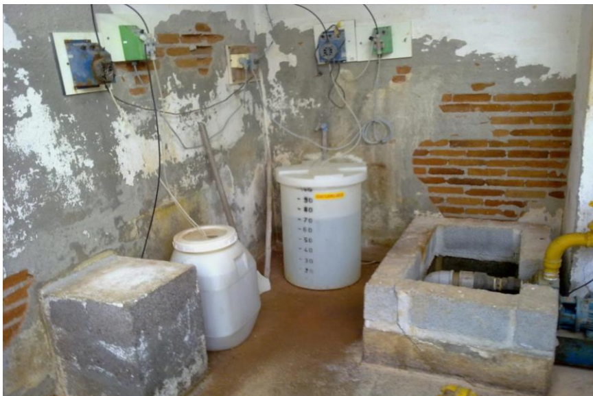
Figura 36 - Bombas dosadoras de cloro e flúor.
