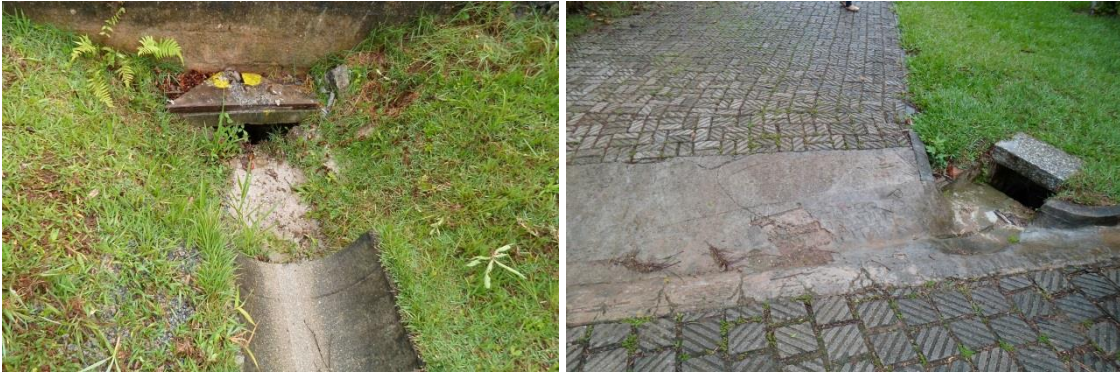
Figura 69 - Valeta de escoamento e boca de lobo.
